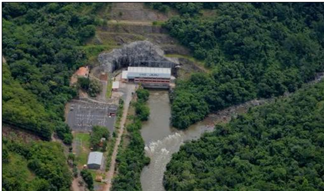
Figura 1 – Barragem da UHE Jauru
