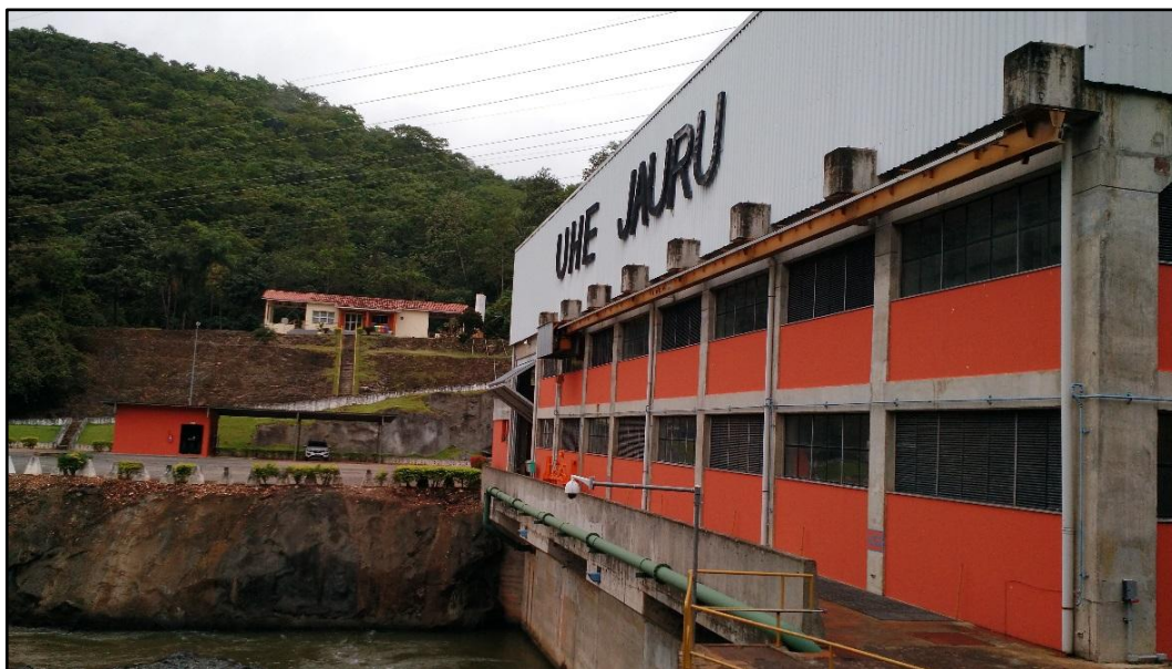
Figura 2 – Instalações da UHE Jauru
